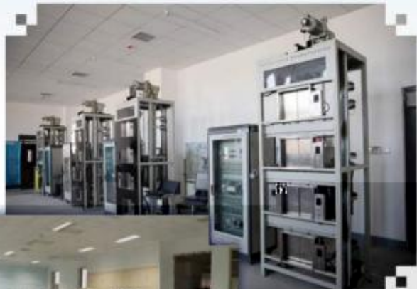
智能电梯安装调试 维护训练场所
